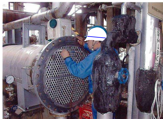
熱交管板チューブの超音波探傷試験
