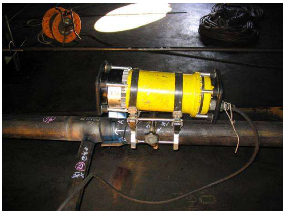
配管溶接部の放射線透過試験
