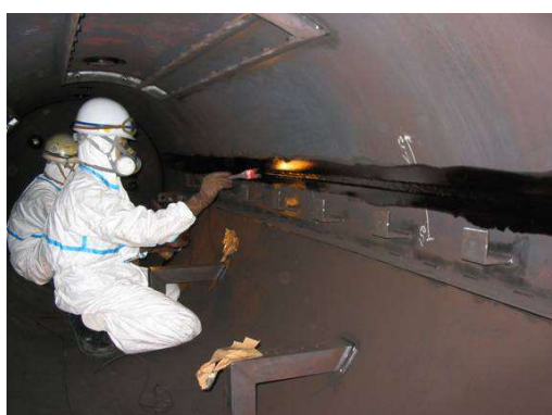
ドラム溶接部、浸透状況
