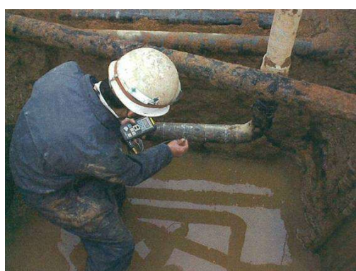
埋設配管の厚さ測定
