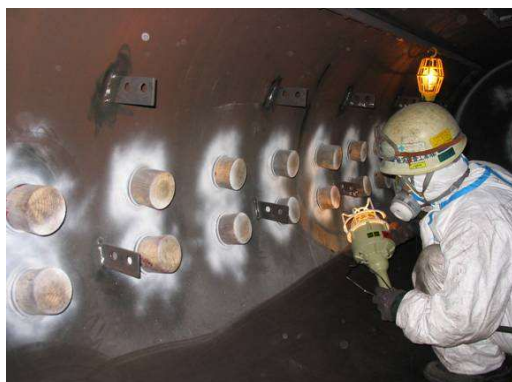
ドラム溶接部、現像状況
