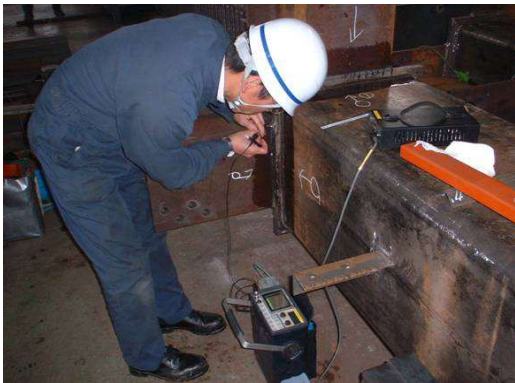
鉄骨溶接部の超音波探傷試験 鉄筋の圧接部の探傷も出来ます。
