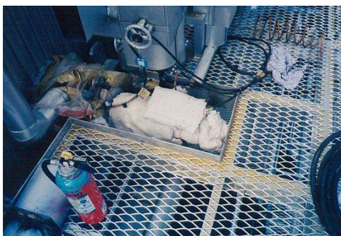
溶接完了後の焼鈍工事
