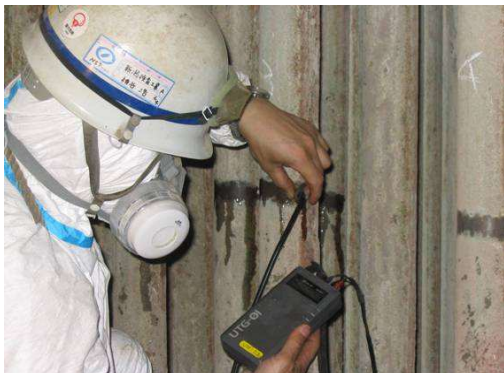
ボイラーチューブの厚さ測定
