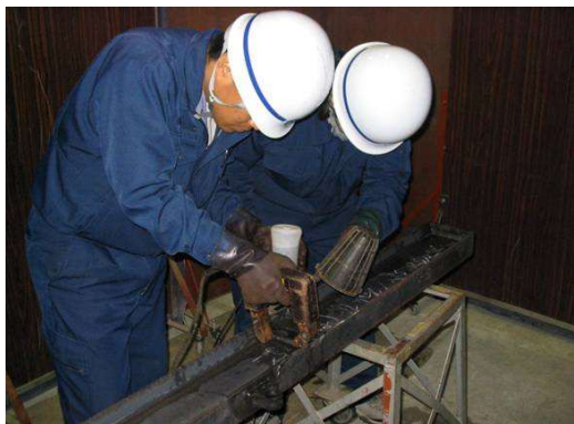
吊金具等の磁粉探傷試験
