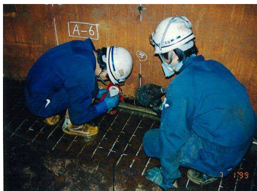
屋外貯槽タンク底板の磁粉探傷試験
