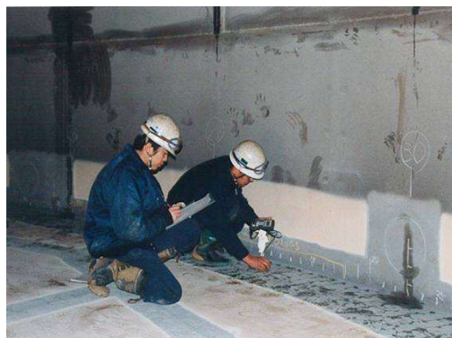
屋外貯槽タンク底板の厚さ測定
