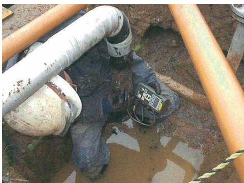
埋設配管の厚さ測定
